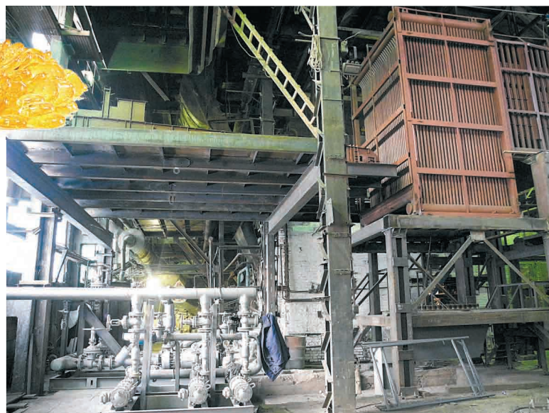
■ Идет монтаж термомасляного котла
