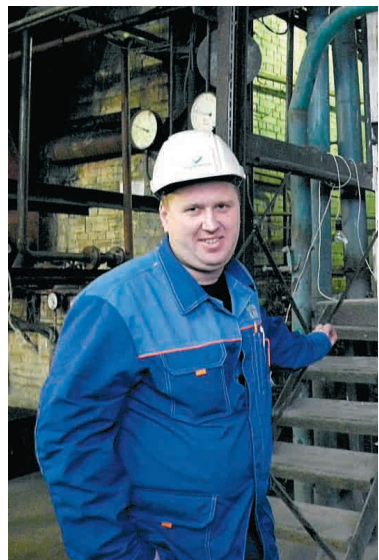
■ Работу котельной контролирует Виталий Сертаков
